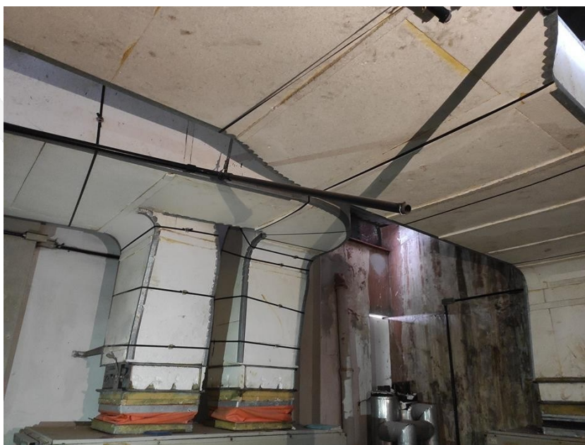
FOTO 11 – C.M 1 2º PAV. – Dutos assim como o isolamento será reaproveitado.
