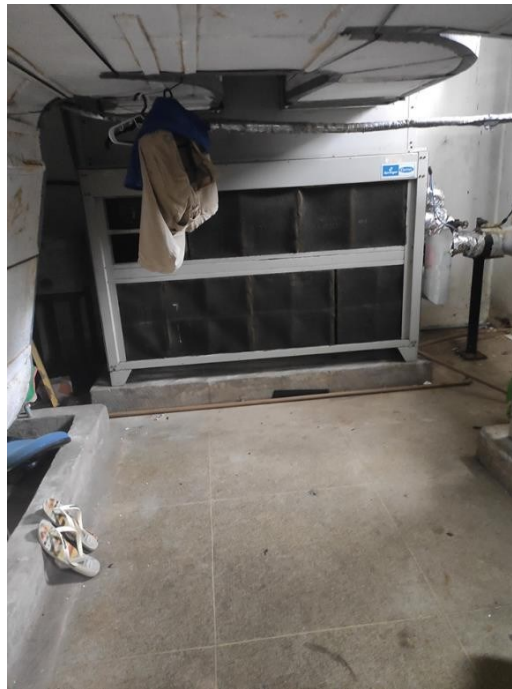
FOTO 7 – C.M 2 – Central da C.M 2 do térreo, possuem 3 splitões de 15 TR.
