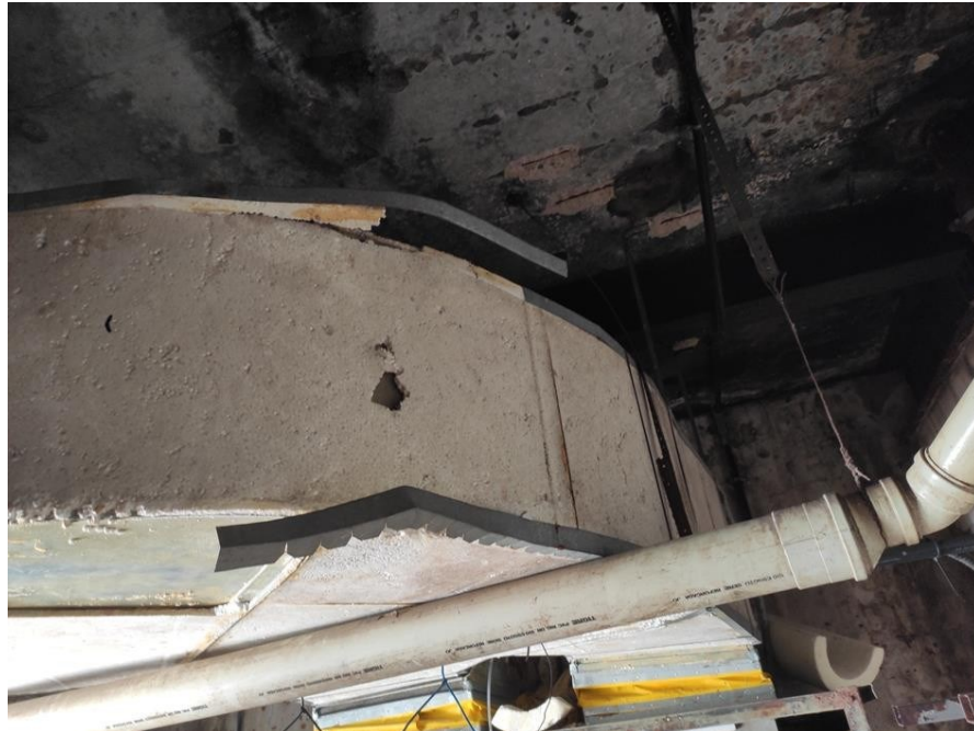
FOTO 3 – C.M 1 – Isolamento do duto danificado.
