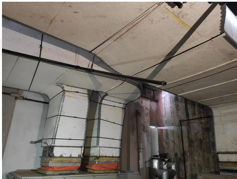
FOTO 11 – C.M 1 2º PAV. – Dutos assim como o isolamento será reaproveitado.
